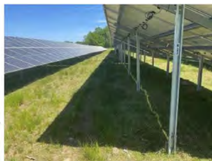
Exemple de structure porteuse de modules photovoltaïque (Sources : Apex Energies)
